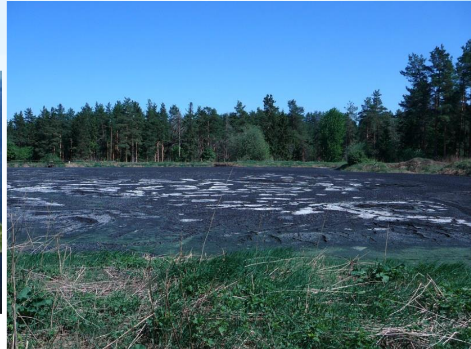
Хранение илового осадка очистных сооружений
