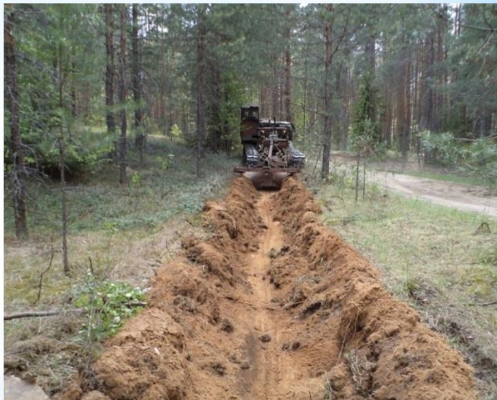
Создание минерализованной полосы
